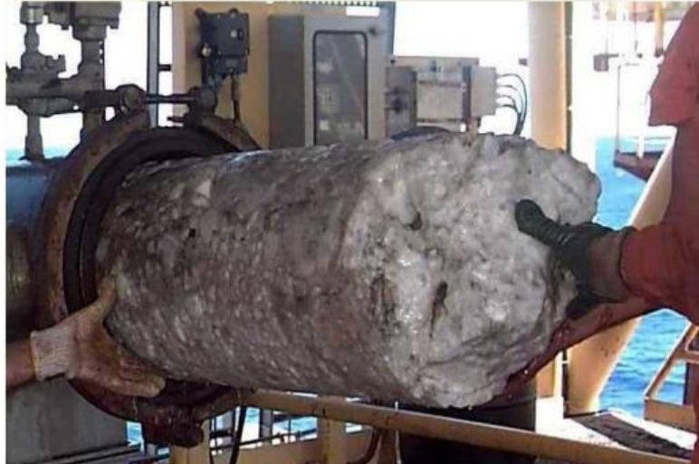
Figura 2 - Hidrato formado no gasoduto da plataforma P-34 da Petrobras
