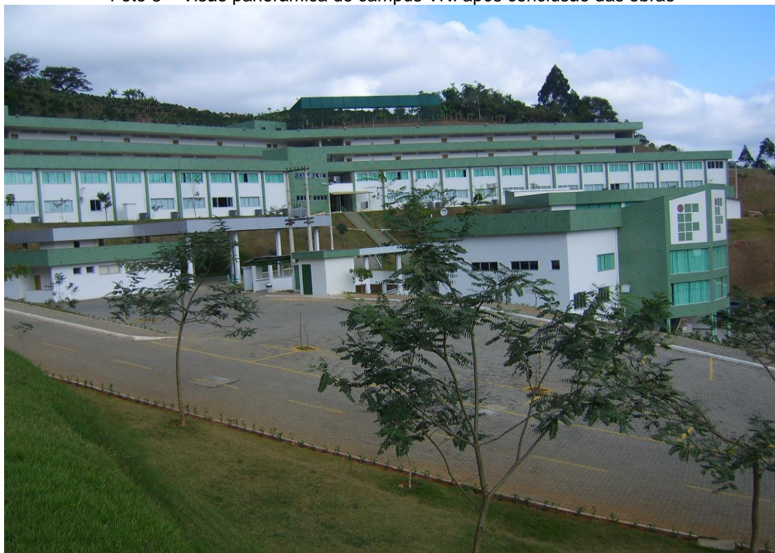
Foto 8 – Visão panorâmica do campus VNI após conclusão das obras
