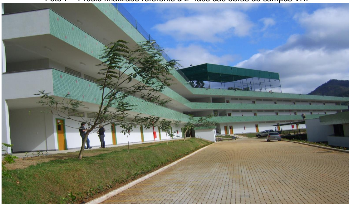
Foto 7 – Prédio finalizado referente à 2ª fase das obras do campus VNI
