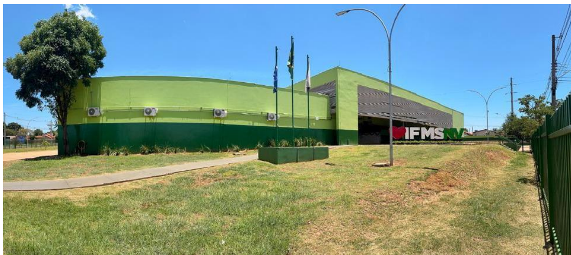
Figura 1 – Vista panorâmica da entrada principal do IFMS de Naviraí.
