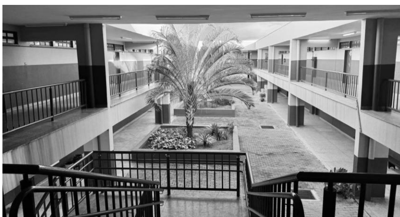
Figura 37 - Segundo Pavimento- Centro Estadual de Educação Profissional Arlindo Neckel - Chapadão do Sul
