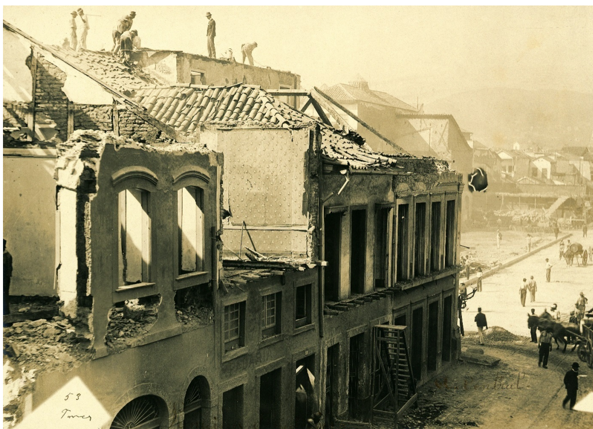
Figura 21 – Demolição de cortiços para início das obras da Avenida Central
