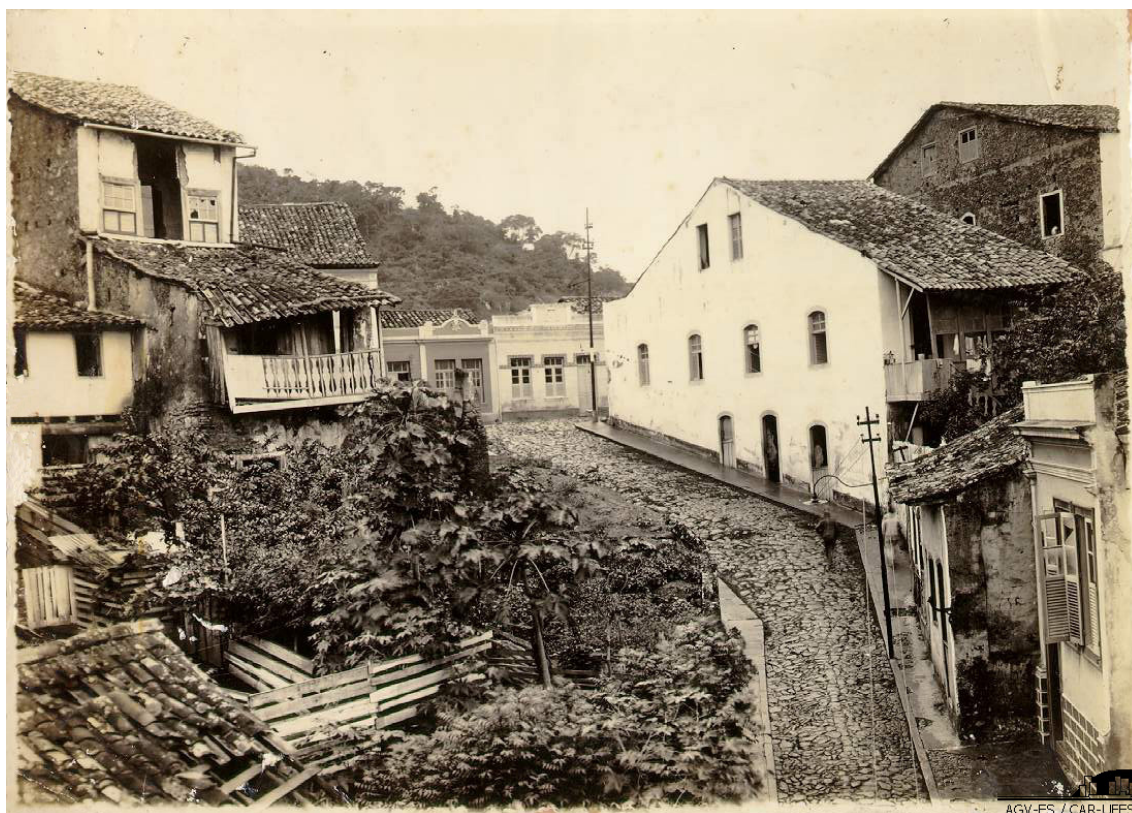
Figura 53 – Ladeira Caramuru, na cidade alta, antes da construção do viaduto
