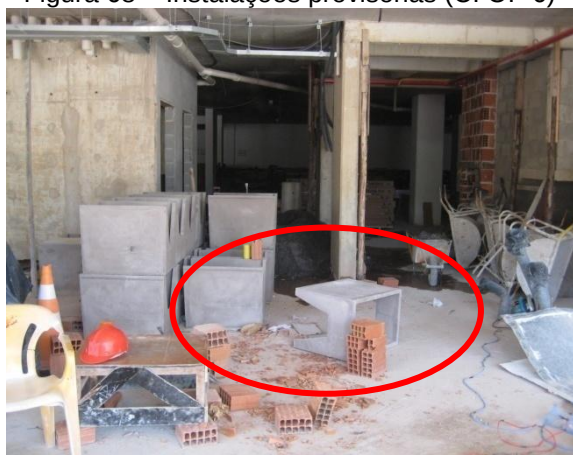
Figura 68 – Instalações provisórias (C. O. -6)
