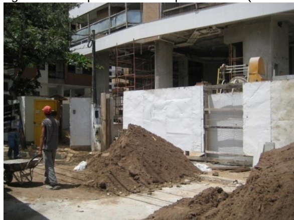
Figura 49 – Tapumes em chapa metálica (C.O. -7)
