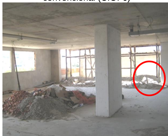
Figura 20 - Realização de reboco externo convencional (C.O.-6)
