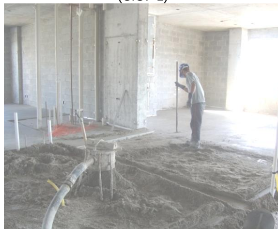
Figura 18 - Realização do contrapiso projetado (C.O. -1)
