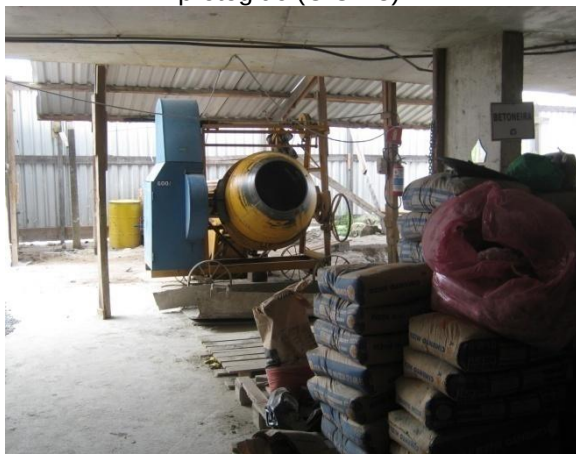
Figura 42 – Preparo de argamassa em local protegido (C.O. -8)
