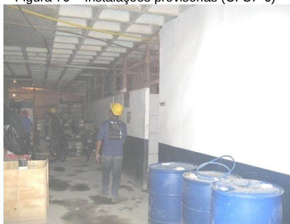
Figura 70 – Instalações provisórias (C. O. -6)
