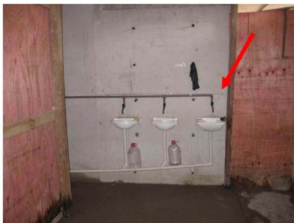
Figura 57 – Lavatório do banheiro (C.O.-8)
