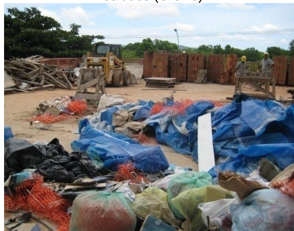
Figura 41 - Espaço destinado a segregação de resíduos (C.O.-8)
