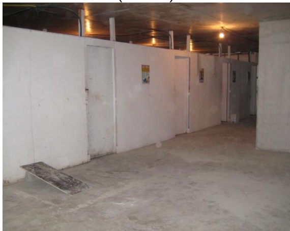
Figura 72 – Corredores de acesso aos vestiários (C. O. -9)
