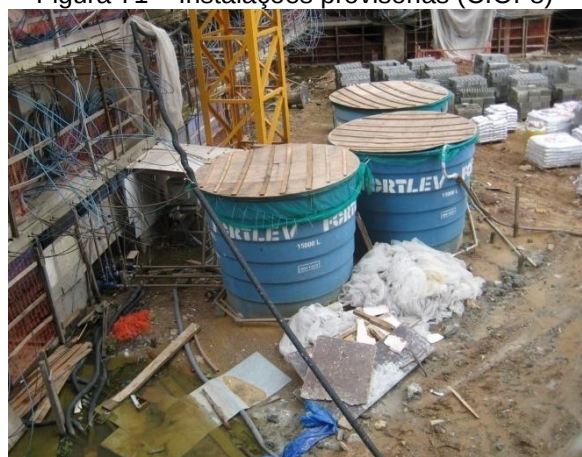
Figura 71 – Instalações provisórias (C.O.-8)
