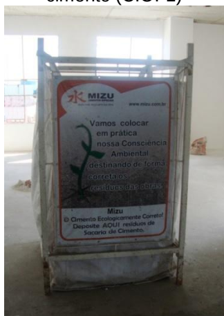
Figura 31– Bag para depósito da sacaria do cimento (C.O.-1)
