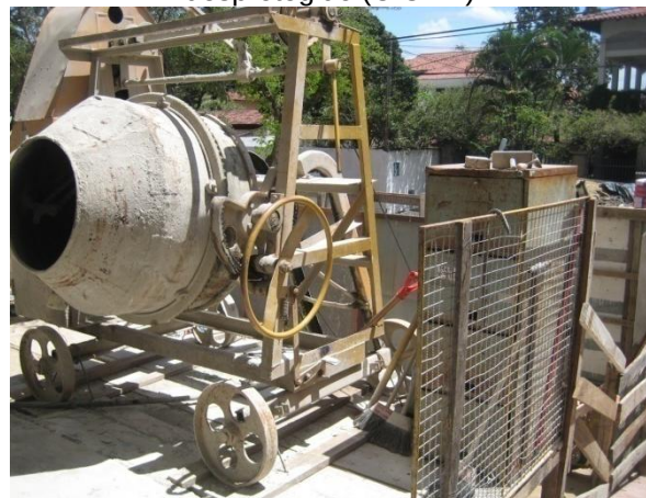
Figura 43– Preparo da argamassa em local desprotegido (C.O. -7)
