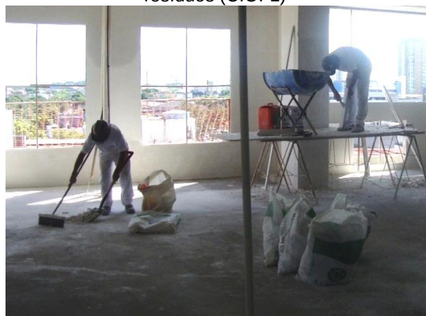
Figura 32 – Aplicadores do gesso recolhendo os resíduos (C.O.-1)
