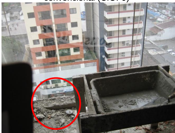
Figura 19 – Realização de reboco interno convencional (C.O.-9)
