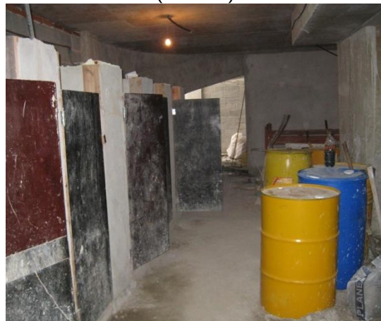
Figura 73 - Corredores de acesso aos banheiros (C. O. -9)
