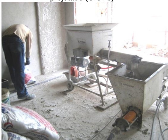
Figura 17 – Realização do reboco interno projetado (C.O.-8)
