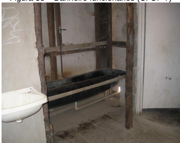
Figura 58 – Banheiro funcionários (C. O. -7)
