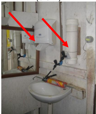
Figura 56 – Lavatório do banheiro (C.O.-2)
