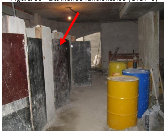
Figura 59– Banheiros funcionários (C.O. -9)
