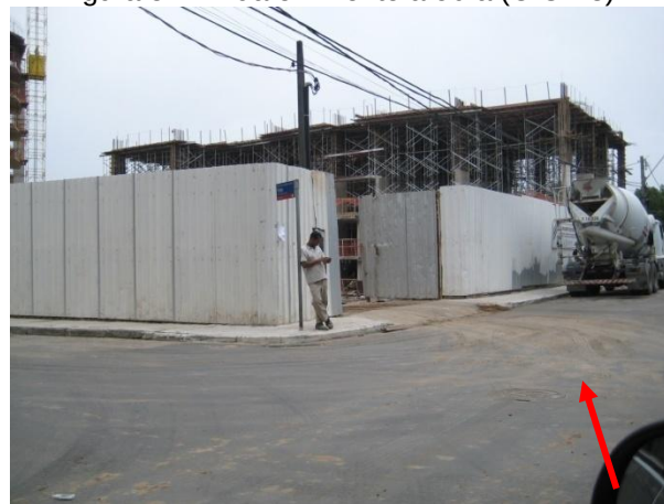
Figura 51 – Rua em frente a obra (C.O. -8)
