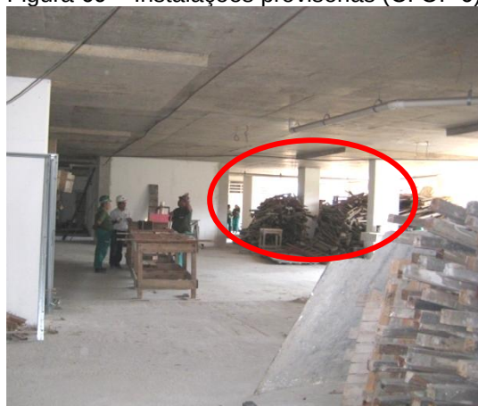
Figura 69 – Instalações provisórias (C. O. -6)
