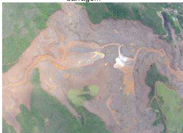
Figura 44 – Córrego Santarém após ruptura barragem 155
