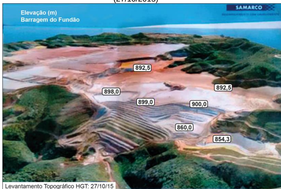
Figura 38 – Cotas de elevação dos alteamentos da barragem de Fundão (27/10/2015)
