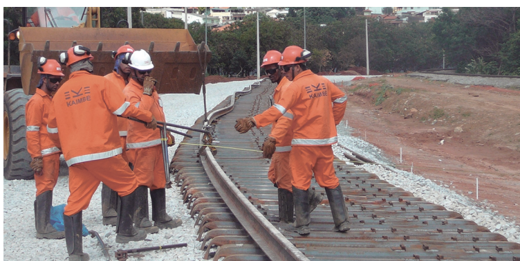
Figura 314 – Colocação dos trilhos sobre as placas de apoio
