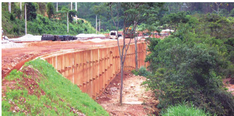
Figura 46 – Aterro concluído com escoramento de cortina atirantada
