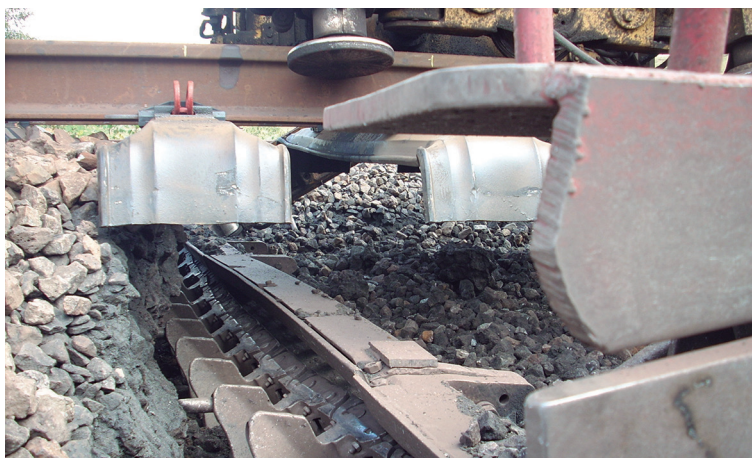
Figura 255 – Detalhe do desguarnecimento de lastro
