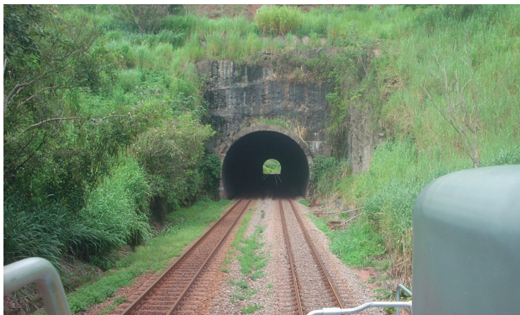
Figura 130 – Túnel com superestrutura já lançada em linha dupla
