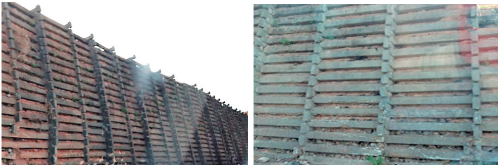
Figuras 36 e 37 – Contenção com crib-walls
