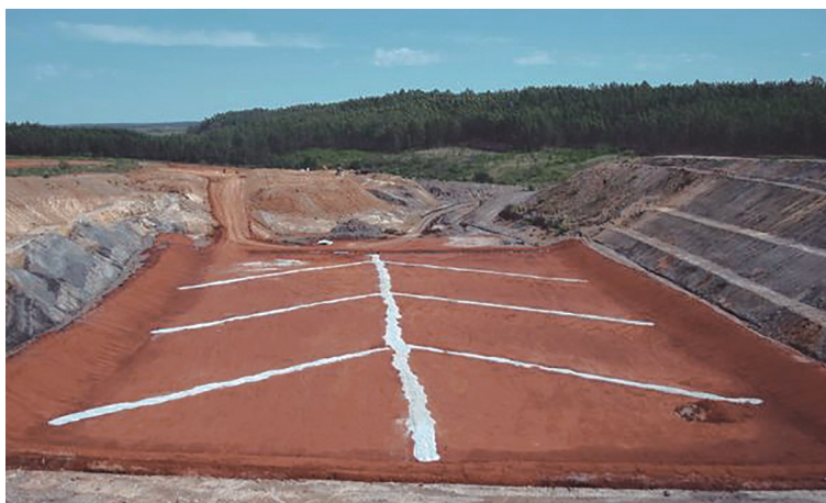
Figura 107 – Drenagem do tipo espinha de peixe
