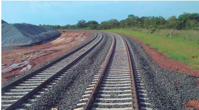
Figura 274 – Dormente de concreto protendido
