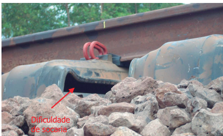
Figura 272 – Falha no lastro por deficiência de socaria
