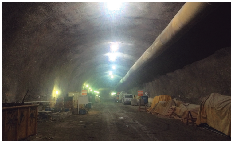
Figura 129 – Túnel preparado para receber a superestrutura
