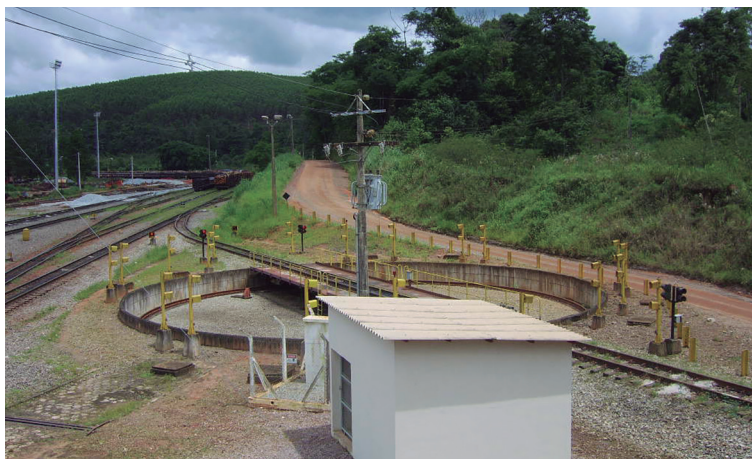
Figura 208 – Virador de locomotiva
