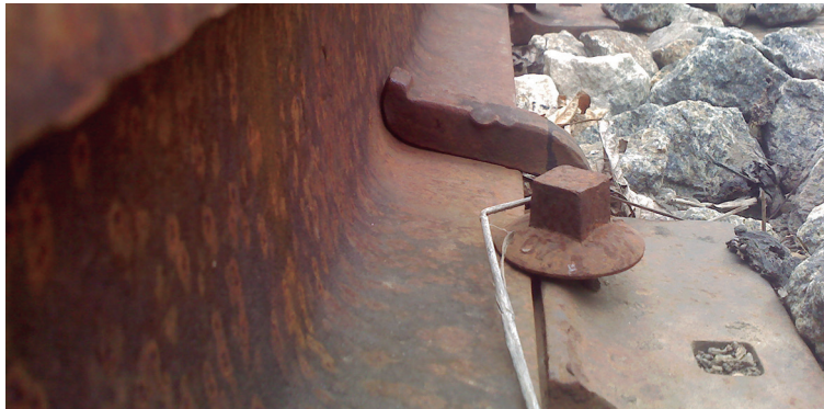
Figura 293 – Tirefond sendo aplicado como fixação rígida da via
