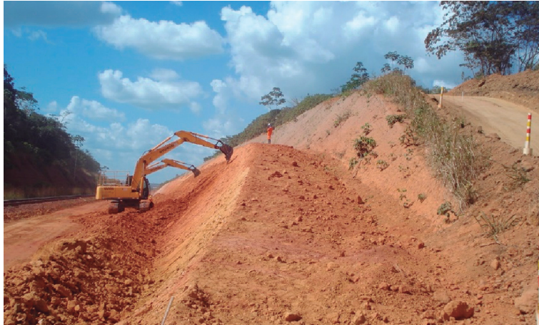
Figura 25 – Talude de corte
