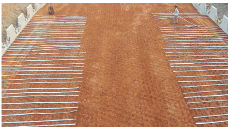
Figura 47 – Terra armada, lançamento da armadura
