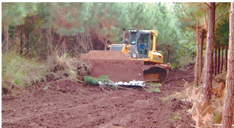
Figura 5 – Trator com lâmina normal promovendo a decapagem
