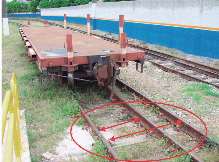
Figura 159 – Ferrovia com bitola mista
