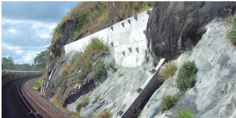
Figura 42 – Aplicação de tirantes para contenção
