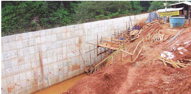
Figura 45 – Processo de aterro com escoramento de cortina atirantada
