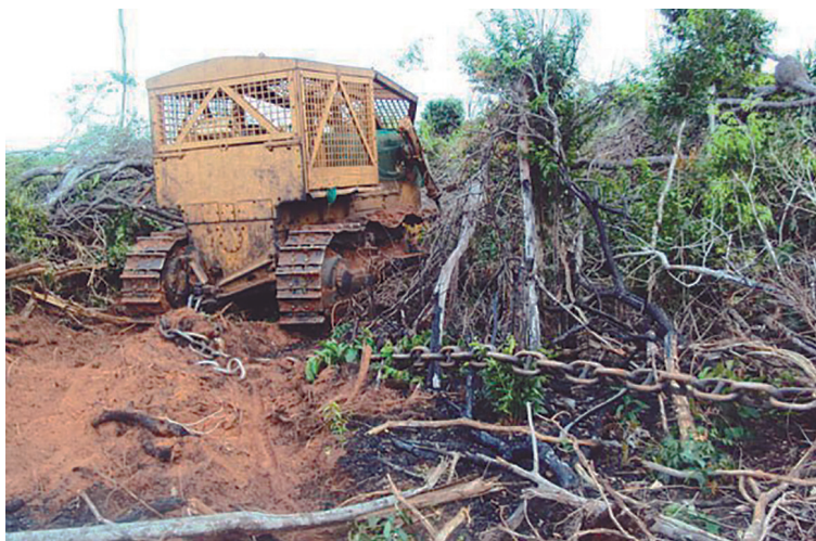
Figura 4 – Trator arrastando corrente para limpeza do terreno
