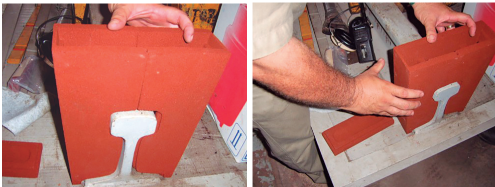
Figura 281 – Solda aluminotérmica – 1ª parte
