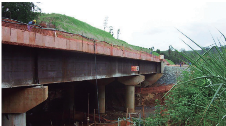
Figura 121 – Ponte ferroviária com tabuleiro misto, aço no vigamento e concreto no estrado
