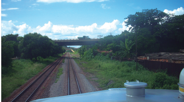
Figura 119 – Passagem superior sobre a ferrovia
