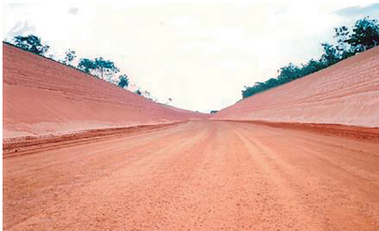
Figura 24 – Plataforma (terrapleno) pronta para receber a superestrutura
