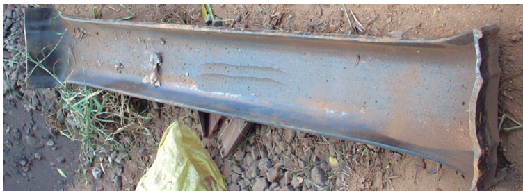
Figura 270 – Dormente de aço com visão da parte inferior
