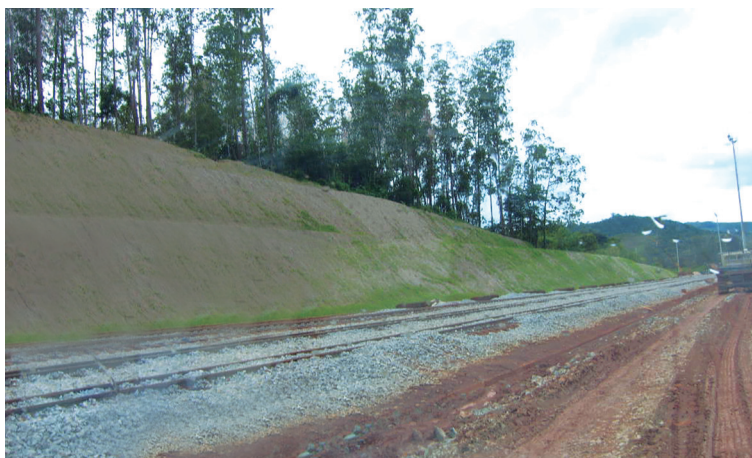
Figura 51 – Proteção superficial em talude (grama)
