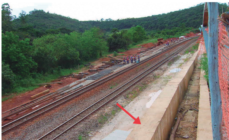
Figura 89 – Valeta na parte de cima do talude
