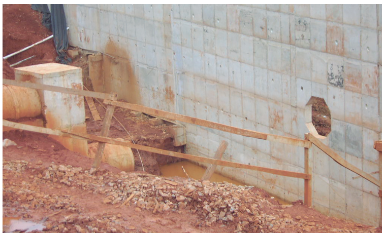
Figura 91 – Detalhe da mudança de nível do bueiro de greide ainda sem o término do aterro
