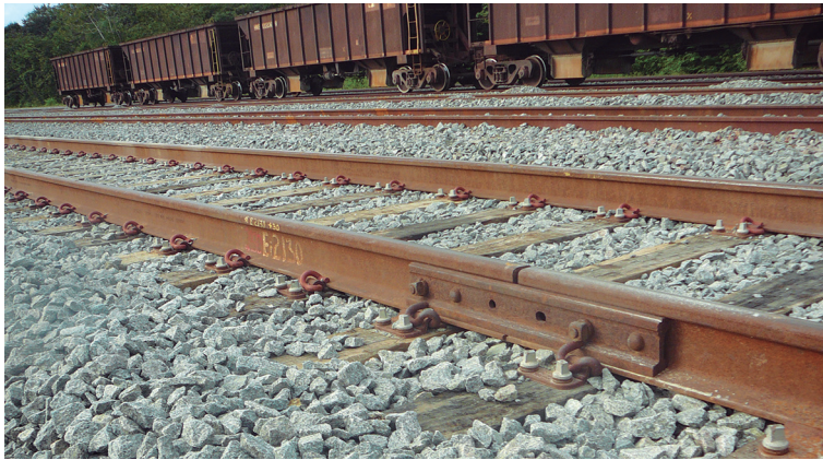
Figura 246 – Lastro em brita
