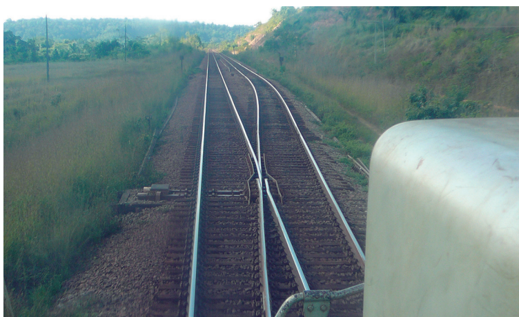
Figura 198 – Jacaré de ponta móvel
