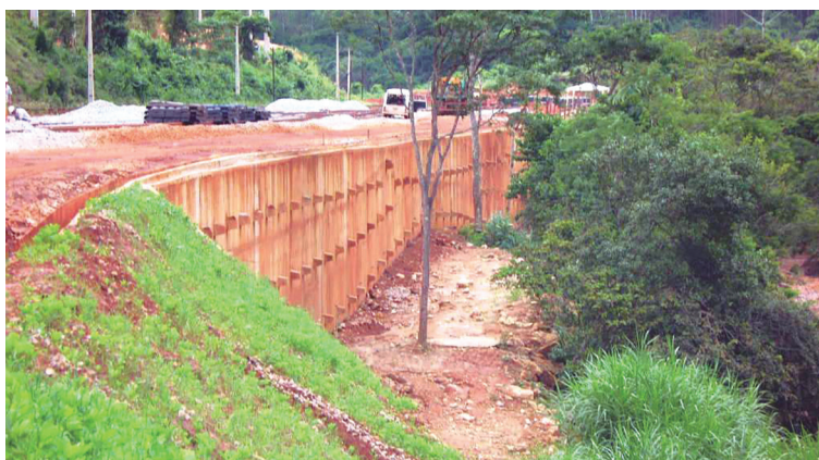
Figura 21 – Aterro concluído com escoramento de cortina atirantada
