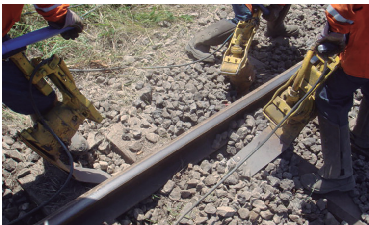
Figura 250 – Detalhe da socaria manual
