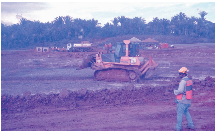
Figura 53 – Trator de esteira em operação
