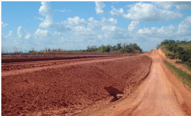
Figura 26 – Talude de aterro
