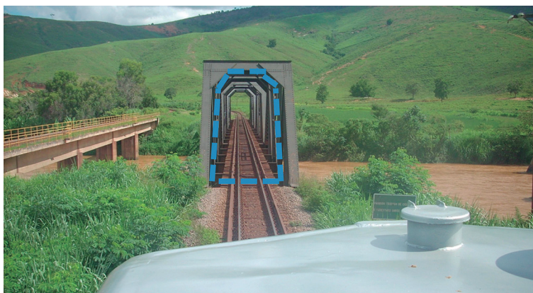
Figura 213 – Gabarito de uma ponte metálica com treliça
