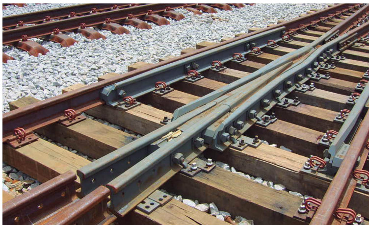
Figura 174 – Vista de um jacaré sendo instalado
