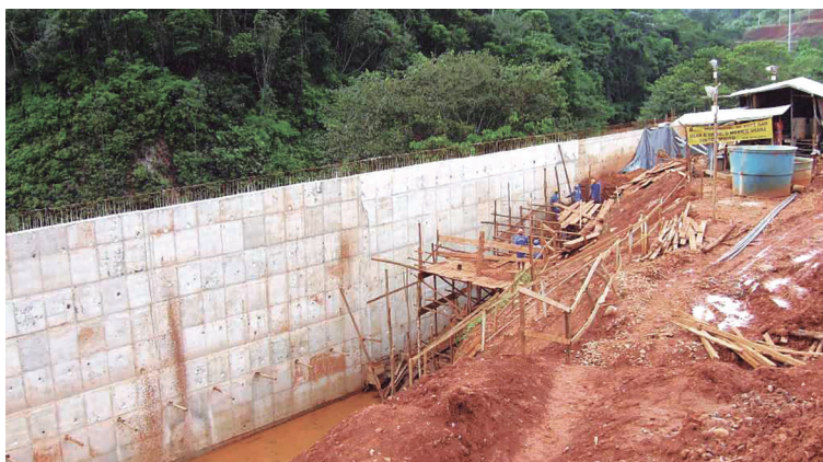
Figura 20 – Processo de aterro com escoramento de cortina atirantada
