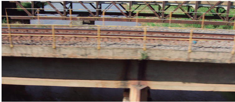
Figura 123 – Ponte em laje de concreto
