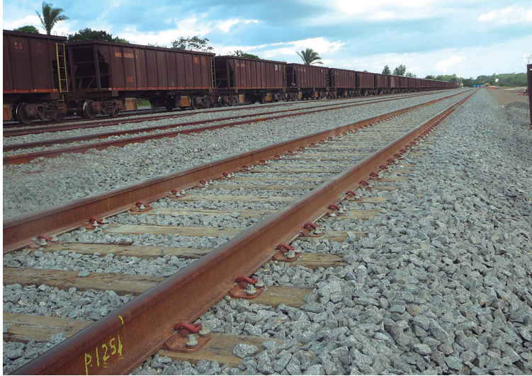
Figura 153 – Vista geral de uma superestrutura lançada
