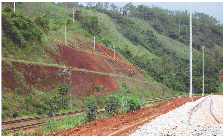
Figura 17 – Corte em solo argiloso
