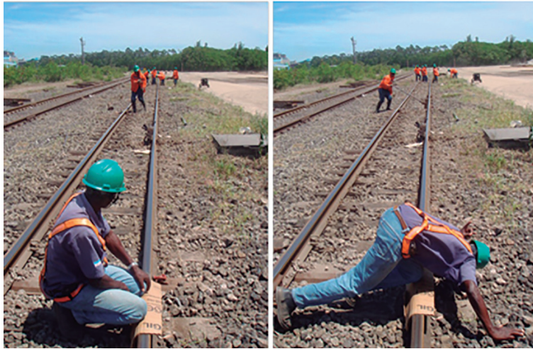
Figura 316 – Alinhamento da linha de forma manual
