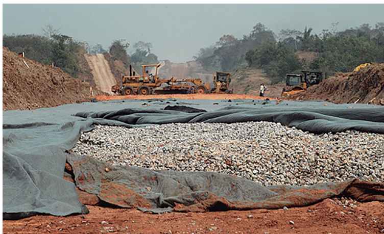
Figura 109 – Colchão drenante em construção
