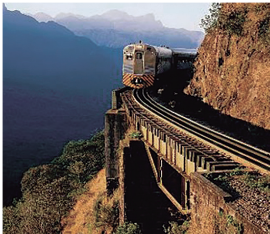
Figura 114 – Viaduto a meia encosta
