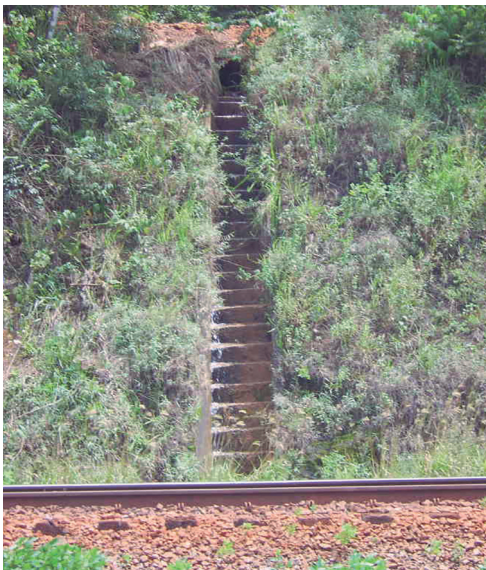
Figura 94 – Escada d'água na saída de um bueiro de greide
