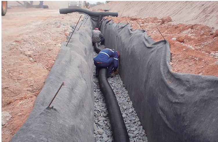
Figura 101 – Obra de implantação de dreno profundo
