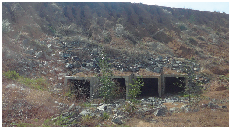
Figura 80 – Bueiro de grota com seção retangular
