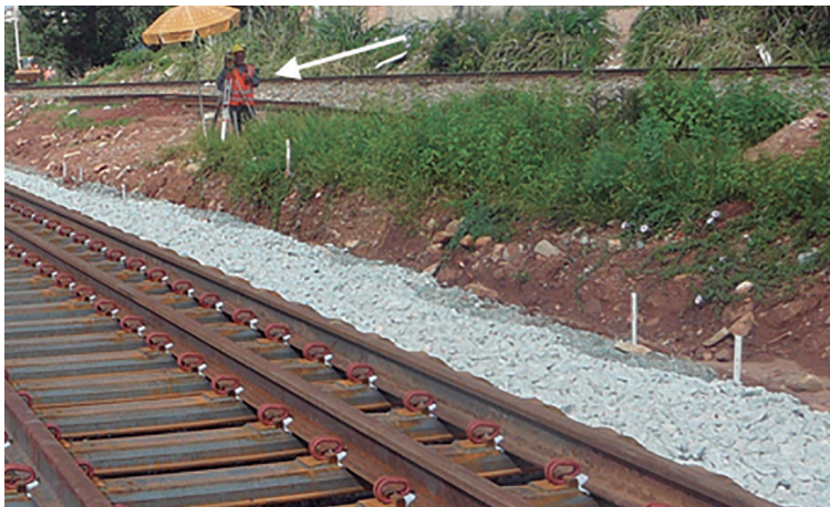
Figura 315 – Alinhamento da linha utilizando a topografia
