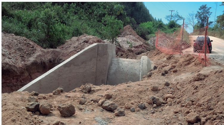
Figura 78 – Bueiro de grotta com seção circular em construção
