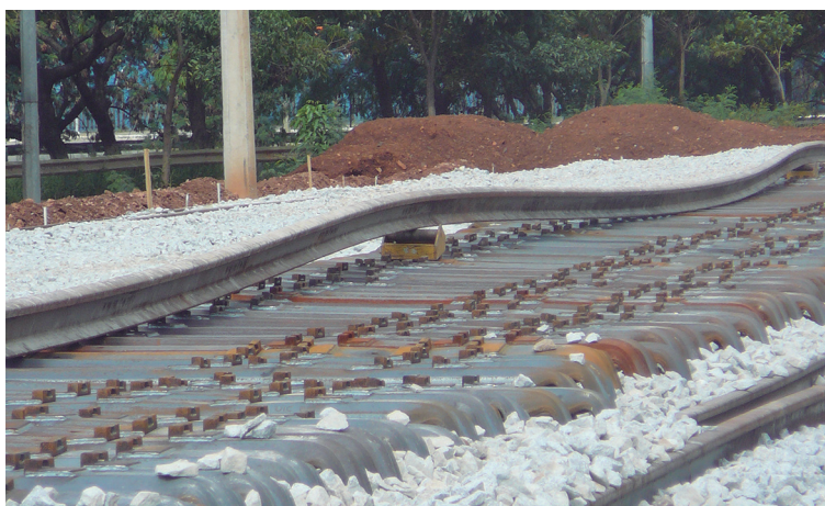
Figura 305 – Aplicação de roletes para alívio de tensões térmicas
