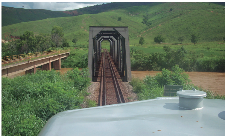
Figura 111 – Pontes ferroviárias, concreto e aço
