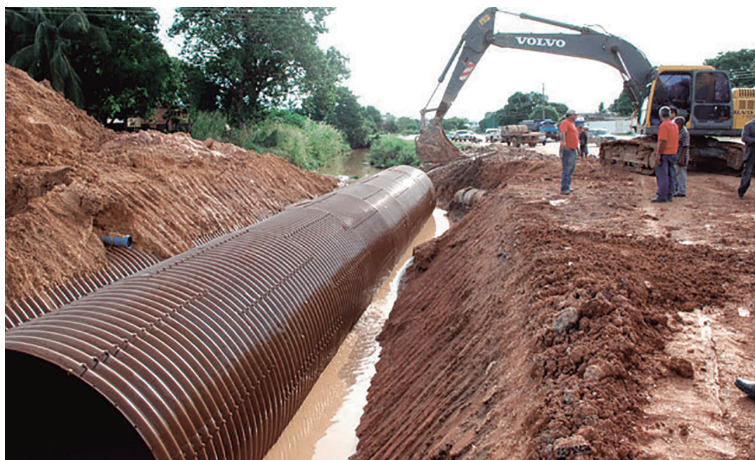
Figura 82 – Bueiro de grotta com corpo metálico corrugado
