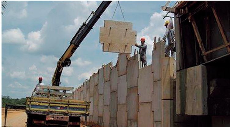
Figura 48 – Colocação das placas de terra armada
