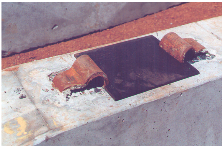
Figura 288 – Almofada utilizada em dormentes de concreto
