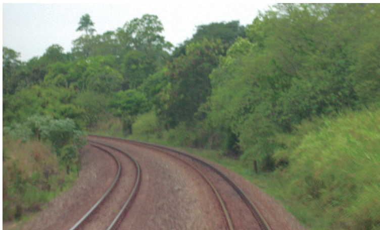
Figura 218 – Trecho em curva
