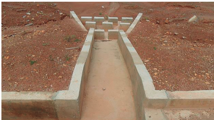
Figura 92 – Caixa de dissipação na parte baixa de descida d'água
