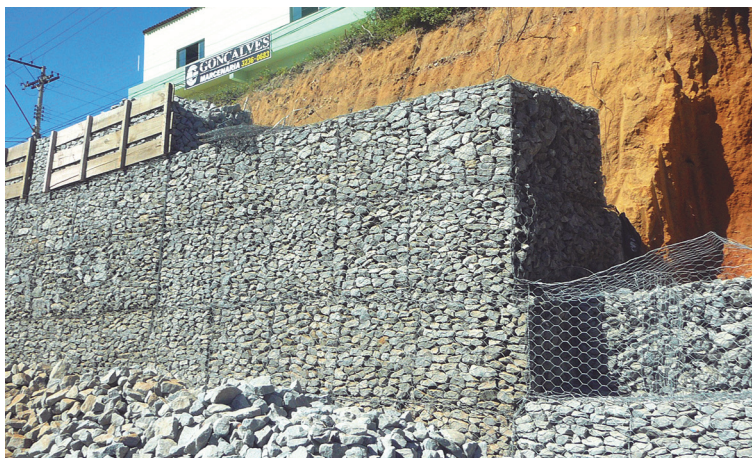
Figura 38 – Muro tipo gabião
