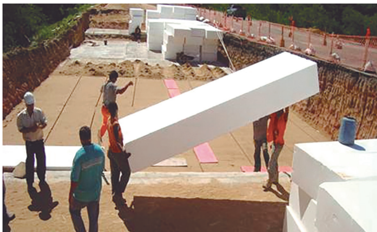
Figura 9 – Aterro utilizando poliestireno expandido
