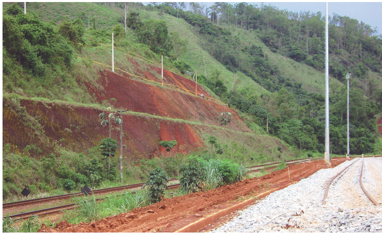
Figura 27 – Corte com um talude executado em berma
