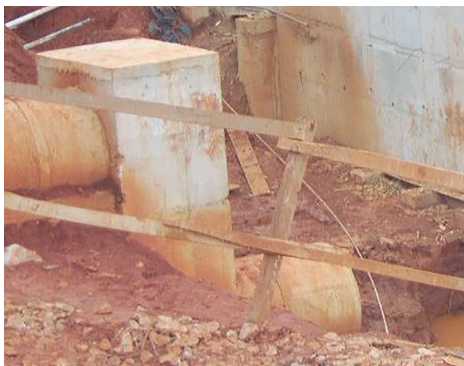
Figura 97 – Bueiro em construção, aguardando colocação final para término do aterro
