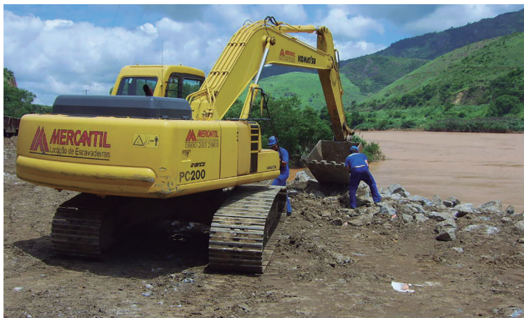
Figura 57 – Escavadeira de esteira
