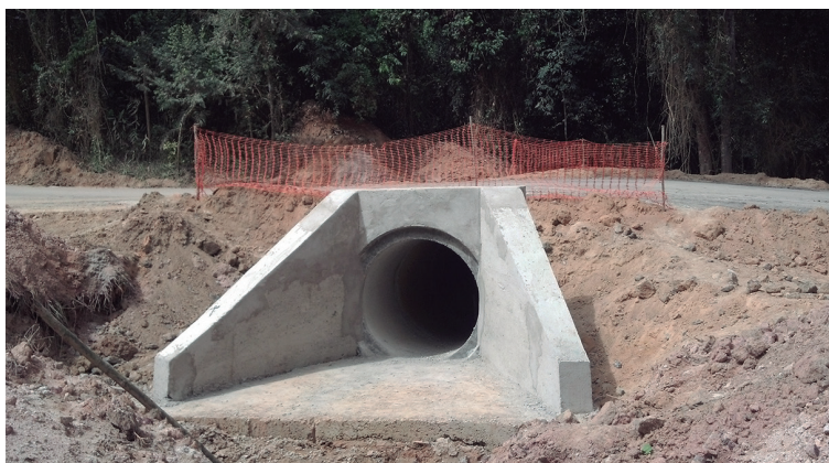
Figura 79 – Bueiro de grotta com seção circular vista frontal
