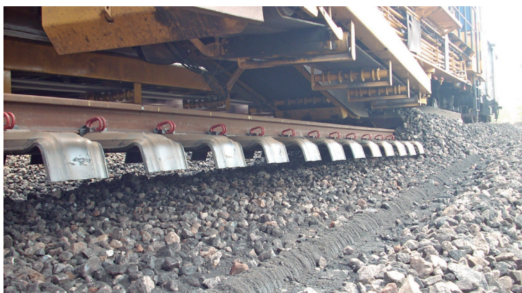
Figura 271 – Dormente de aço sendo aplicado na via
