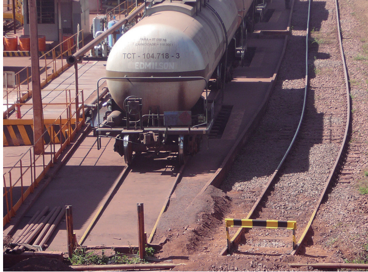
Figura 161 – Para-choques de via
