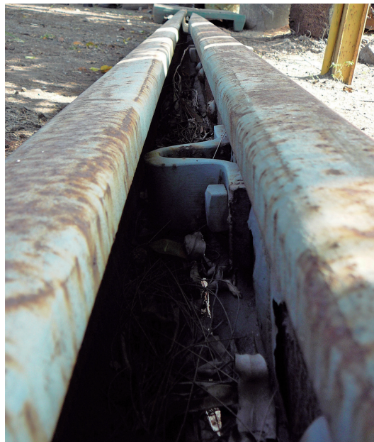
Figura 184 – Calço espaçador
