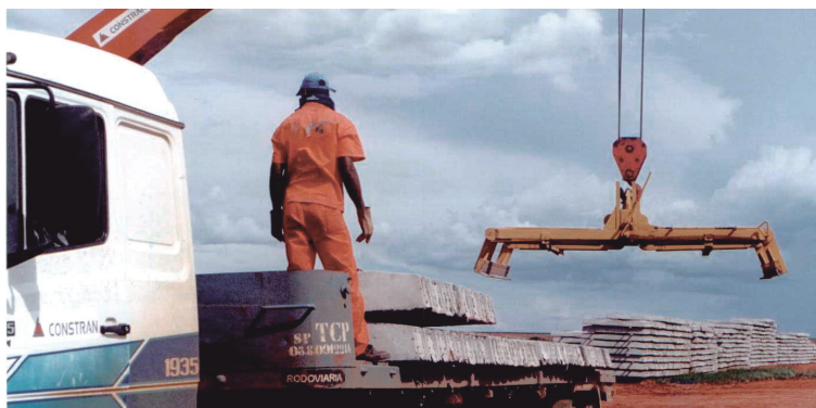
Figura 309 – Distribuição de dormentes ao longo da via
