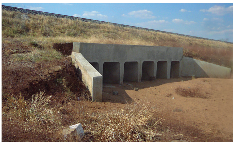
Figura 77 – Boca de um bueiro de grota com seção retangular com diversas seções
