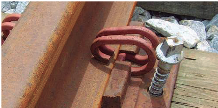
Figura 294 – Tirefond sendo aplicado para fixar placa de apoio
