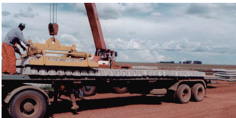
Figura 310 – Distribuição de dormentes ao longo da via
