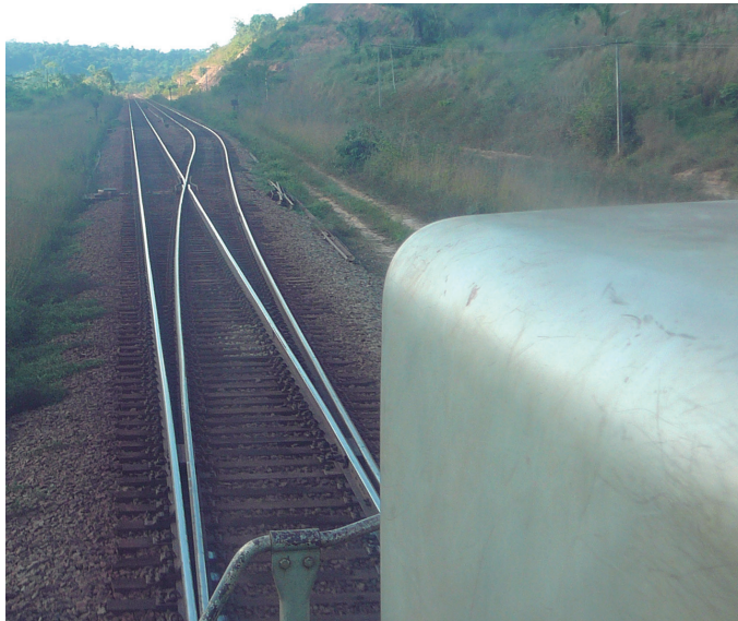
Figura 164 – Entrada de um pátio de cruzamento
