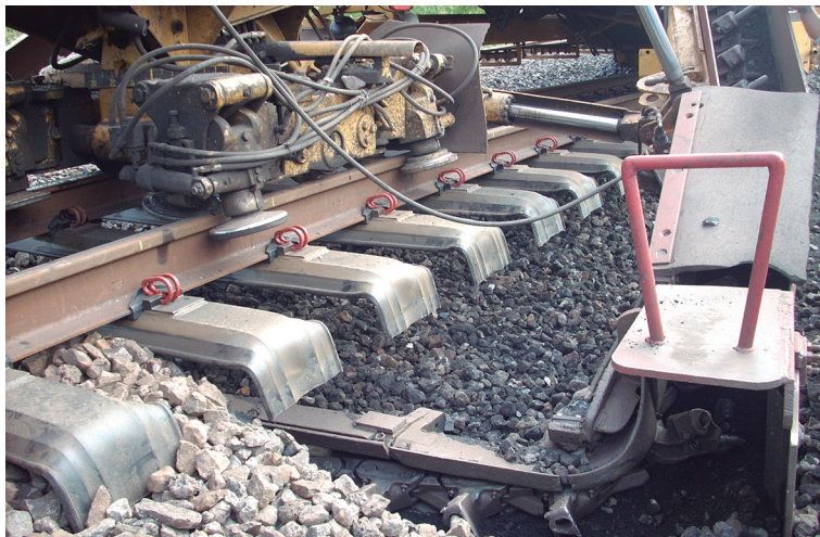
Figura 254 – Visão da desguarnecedora de lastro operando
