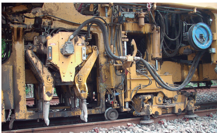
Figura 322 – Detalhe das patas de socaria (fora do lastro) da socadora de lastro
