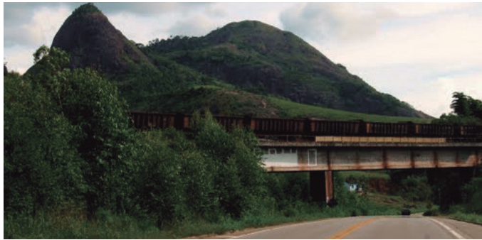
Figura 117 – Viaduto em João Neiva
