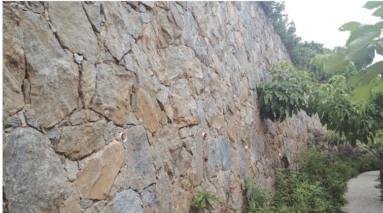
Figura 35 – Muro de arrimo tipo “gravidade”
