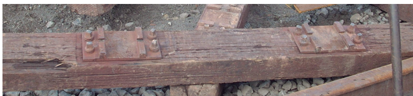
Figura 285 – Placa de apoio fixada com tirefond em dormente de madeira
