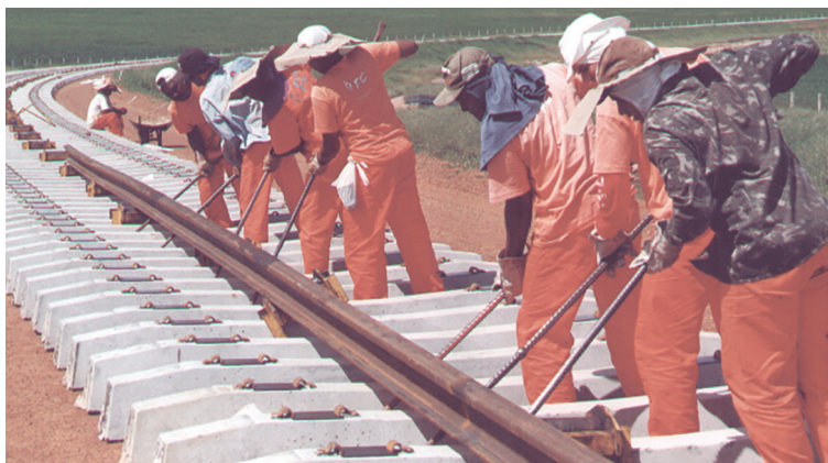
Figura 313 – Colocação dos trilhos sobre as placas de apoio
