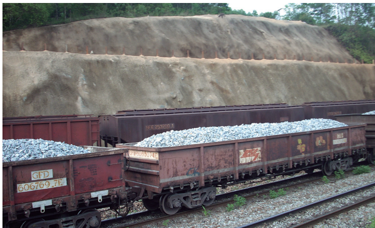
Figura 50 – Proteção superficial em talude (concreto projetado)
