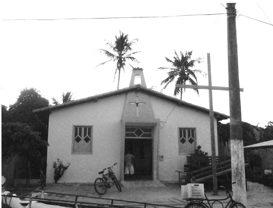
Igreja de São Bartolomeu, em etapa de reforma.
