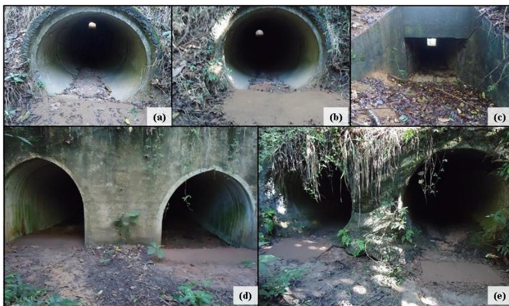
Figura 02 - Estruturas de drenagem existentes no trecho da Rodovia BR-101 que intercepta a Reserva Biológica de Sooretama. Estrutura A (bueiro simples tubular de concreto), Estrutura B (bueiro simples tubular de concreto), Estrutura C (galeria celular de concreto), Estrutura D (galeria tipo porta de concreto) e Estrutura E (bueiro duplo tubular metálico). Crédito fotográfico: Fabiana Cruz.
