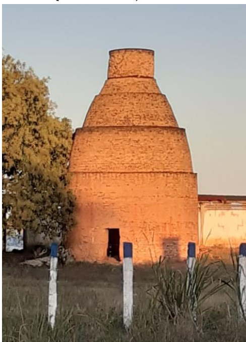
Fotografia 32 – Fornalha da Serraria Sayonara (BR-101, bairro Sayonara, Conceição da Barra)
