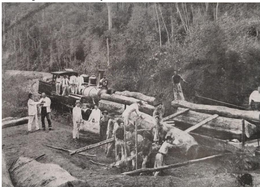
Fotografia 28 – Embarque de madeira em locomotiva da EFVM
