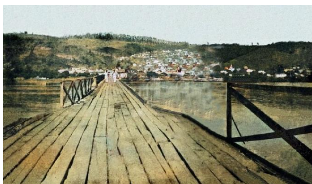
Fotografia 4 – Ponte sobre o rio Doce em Colatina (Piso de madeira)
