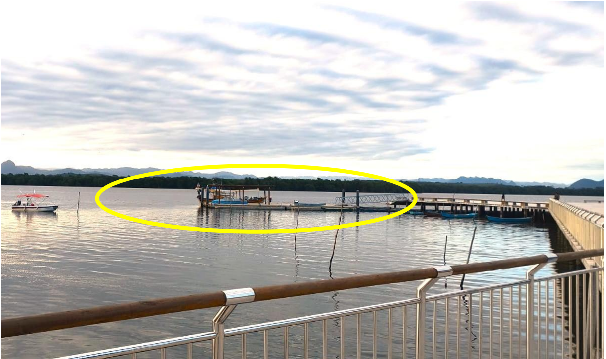
Figura 26 - Píer construído sobre o pesqueiro mais antigo da orla
