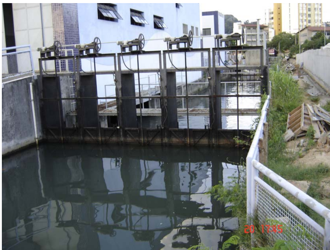
Figura 56. Comportas para retenção do fluxo da maré [em situação fechada], localizada na galeria do Bairro Bento Ferreira, à Rua Jair Etienne Dessaune. Registro fotográfico obtido às 17h 45min, do dia 20/02/2007, 25 min após a preamar.
