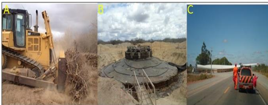
Figura 16 - Etapas da construção de aerogeradores
