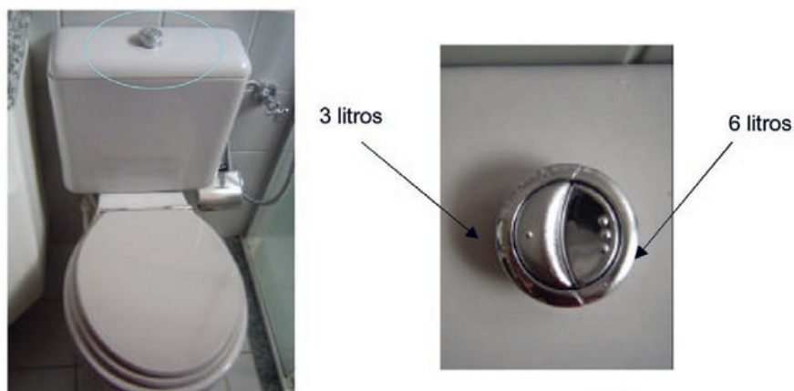
Figura 3. Bacia sanitária com válvula de descarga com duplo acionamento
