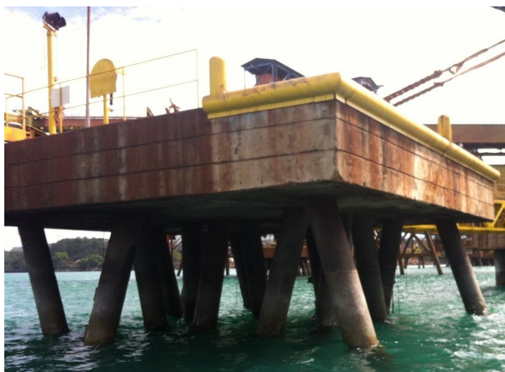
Figura 13 – Dólm de amarração (Fonte: Arquivo técnico da Vale S.A. (2018))
