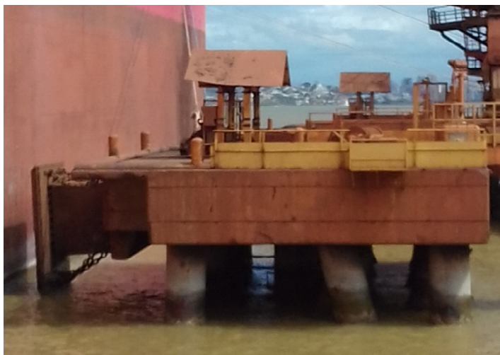
Figura 12 – Dólfim de atracação (Fonte: Arquivo técnico da Vale S.A. (2018))
