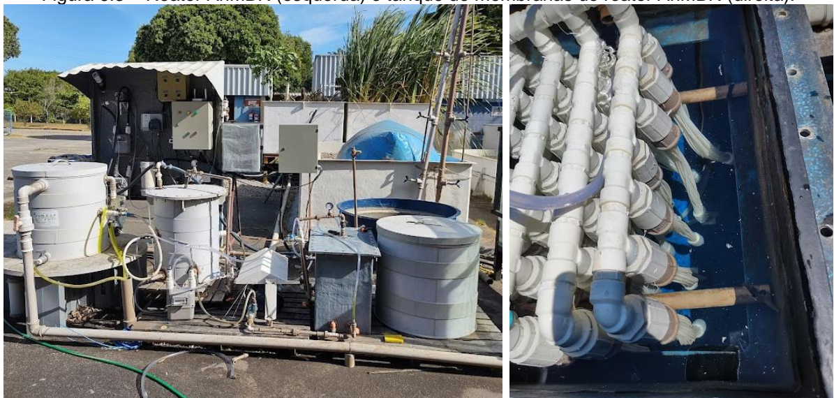
Figura 6.3 – Reator AnMBR (esquerda) e tanque de membranas do reator AnMBR (direita).
