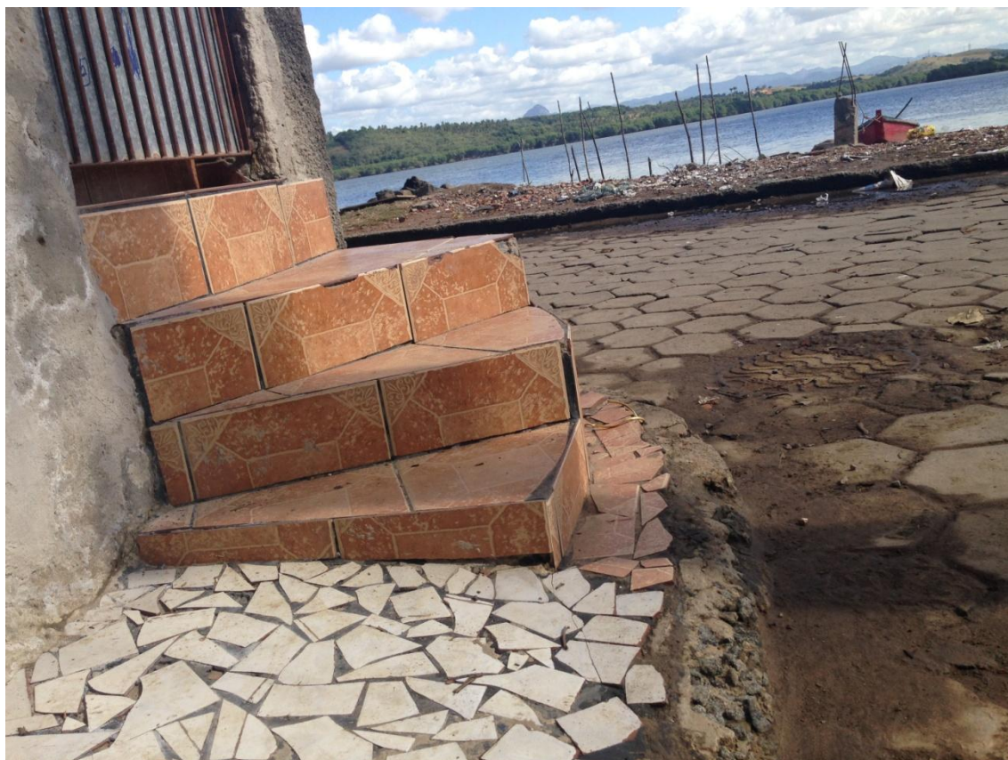
Foto 13. Casa construída sobre elevado - Rua do Canal. Fonte: Fernando Sartório, 14 jan de 2014.
