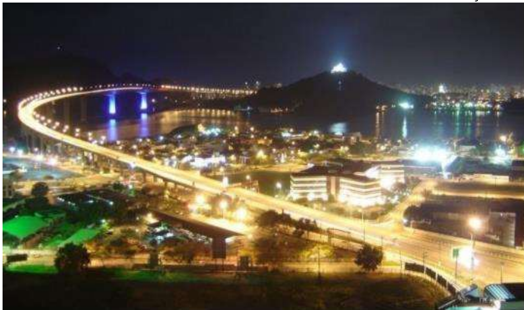
Figura 93- Vista noturna da cidade da Terceira Ponte - Vitória/Vila Velha - ES, Março de 2019.
