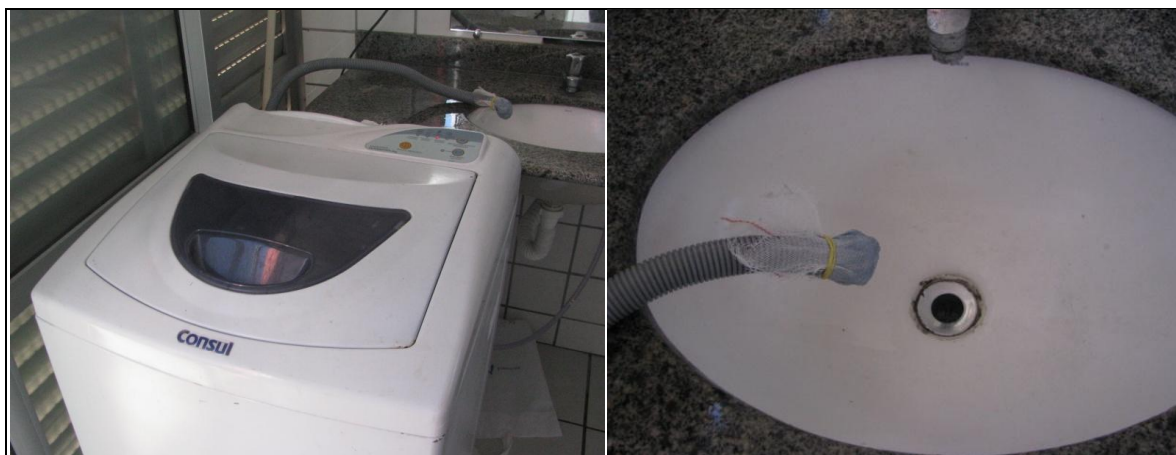
Figura 11. Malha na mangueira de saída da máquina de lavar.
