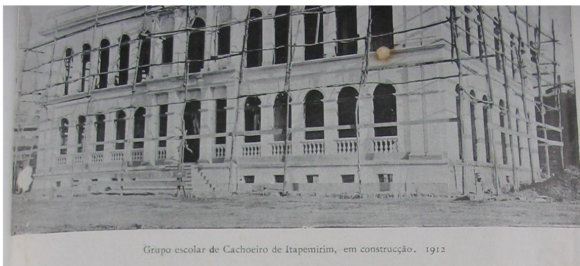
Figura 17 – Grupo Escolar Bernardino Monteiro em construção.
