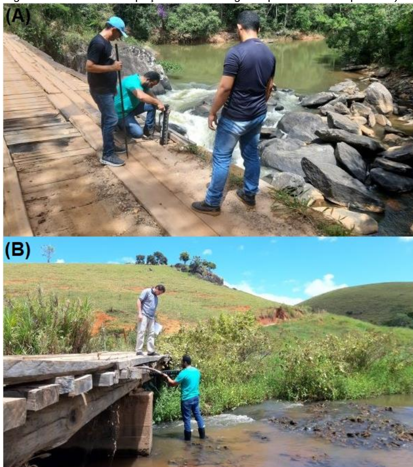
Figura 17. Pontos de inspeção com resistografia próximos aos apoios: A) Ponte 35; B) Ponte 49.
