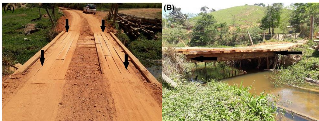
Figura 24. Pontos de inspeção com resistografia próximos aos apoios da ponte 20: A) Visão por cima do tabuleiro na direção externa do rodeiro; B) Visão lateral da longarina de madeira roliça.
