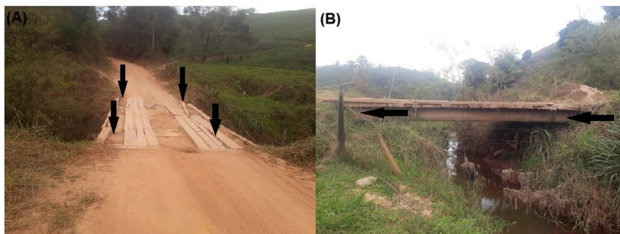
Figura 18. Pontos de inspeção com resistografia próximos aos apoios da ponte 01: A) Visão por cima do tabuleiro; B) Visão lateral da longarina de madeira roliça.
