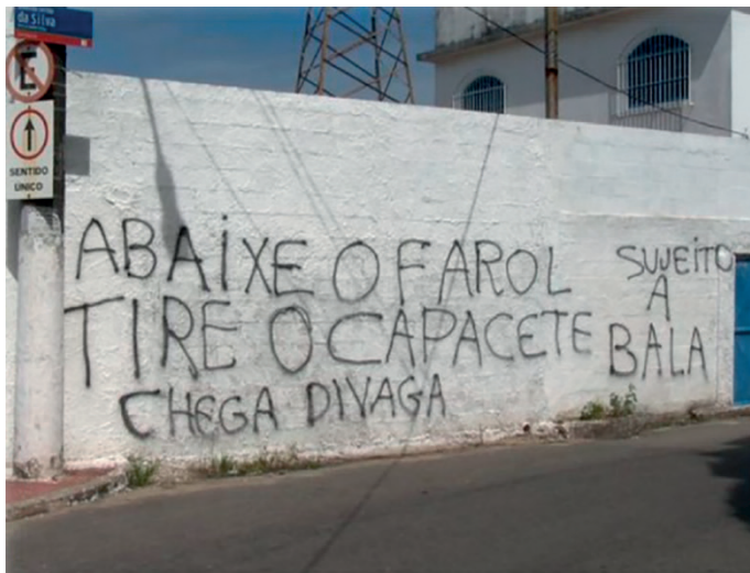
Figura 2 – Pichações no muro da comunidade
