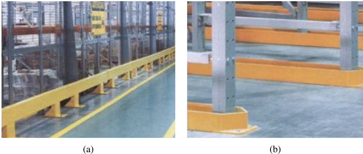
(a) (b) Figura 3.18 – Elementos de proteção: a) barra horizontal de proteção ( guard-rail ); b) guia para empilhadeiras ( guide-rail ), (Águia, 2005a).
