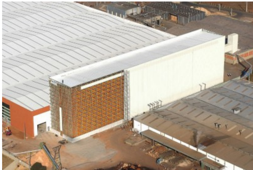
Figura 2.1 – Sistemas de armazenagem industrial autoportante, (Águia, 2005).
