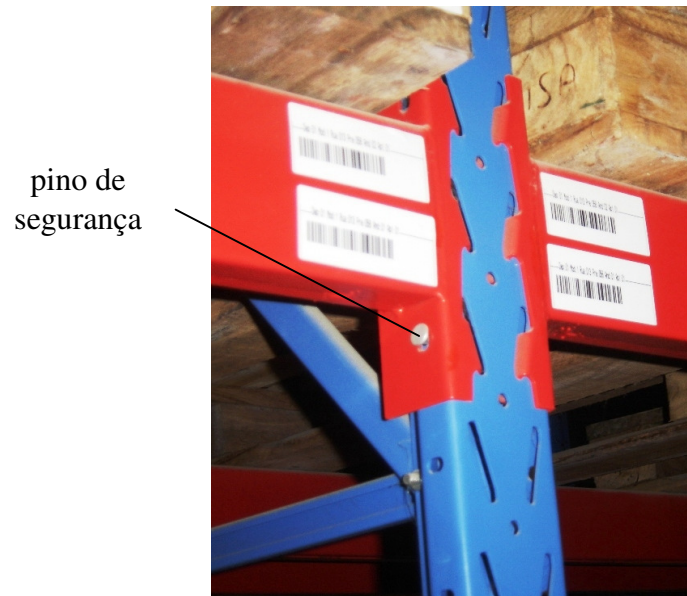
Figura 3.20 – Foto da ligação por meio de garra dentada com detalhe do pino de segurança.
