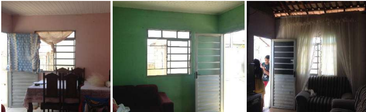
Figura 27. Acabamento interno de sala: a – pintura sobre bloco de concreto, forro em PVC, piso cerâmico claro; b – pintura sobre bloco de concreto, piso cerâmico claro e forro em PVC; c – bloco de concreto aparente, sem forro, piso em cimento queimado.
