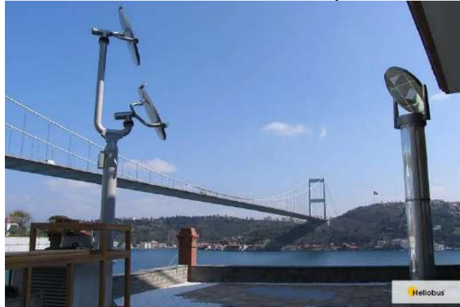
Figura 15. Tubo de luz natural associado a um heliostato para rastreamento e desvio da luz.
