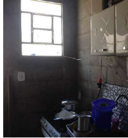
Figura 25. Acabamento interno de cozinha: a – acabamento de parede em cerâmica decorada e pintura sobre bloco de concreto; b – acabamento de parede em cerâmica clara e pintura sobre bloco de concreto; c – acabamento de parede em cerâmica, altura inferior a 1,5m e bloco de concreto aparente.
