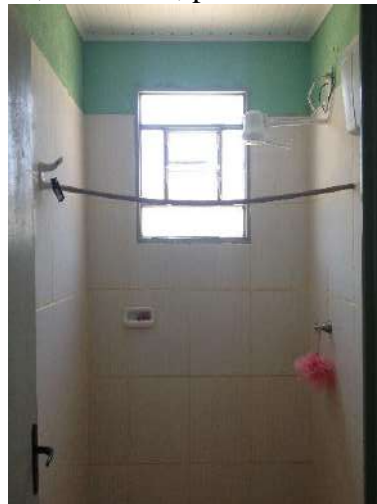
Figura 26. Acabamento interno de banheiro: a – acabamento de parede em cerâmica clara, forro em PVC, piso cerâmico claro; b – acabamento de parede em cerâmica clara, pintura sobre bloco de concreto, piso cerâmico claro e forro em PVC; c – acabamento de parede em cerâmica clara, sem forro, piso em cimento queimado.
