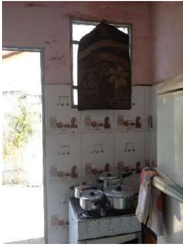
Figura 25. Acabamento interno de cozinha: a – acabamento de parede em cerâmica decorada e pintura sobre bloco de concreto; b – acabamento de parede em cerâmica clara e pintura sobre bloco de concreto; c – acabamento de parede em cerâmica, altura inferior a 1,5m e bloco de concreto aparente.
