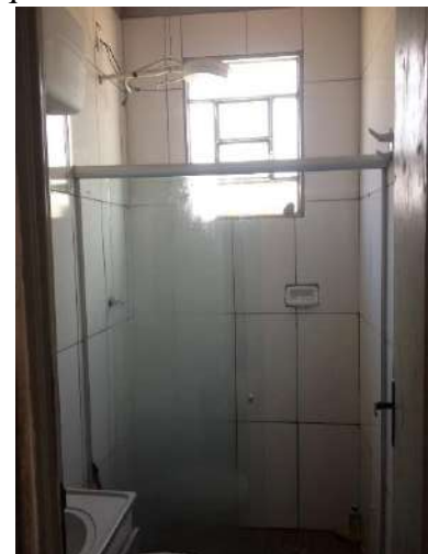
Figura 26. Acabamento interno de banheiro: a – acabamento de parede em cerâmica clara, forro em PVC, piso cerâmico claro; b – acabamento de parede em cerâmica clara, pintura sobre bloco de concreto, piso cerâmico claro e forro em PVC; c – acabamento de parede em cerâmica clara, sem forro, piso em cimento queimado.
