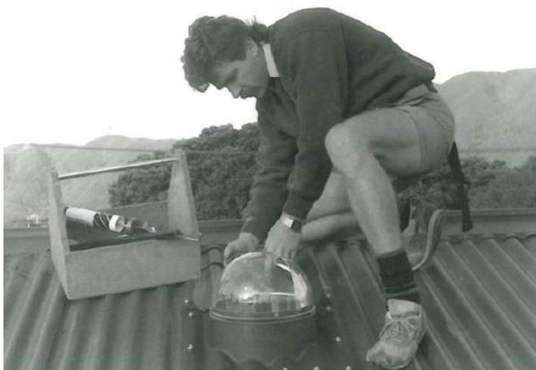
Figura 12. Instalação da claraboia tubular SOLATUBE.
