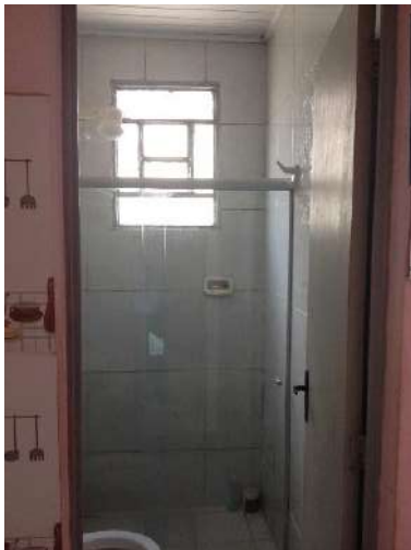
Figura 26. Acabamento interno de banheiro: a – acabamento de parede em cerâmica clara, forro em PVC, piso cerâmico claro; b – acabamento de parede em cerâmica clara, pintura sobre bloco de concreto, piso cerâmico claro e forro em PVC; c – acabamento de parede em cerâmica clara, sem forro, piso em cimento queimado.
