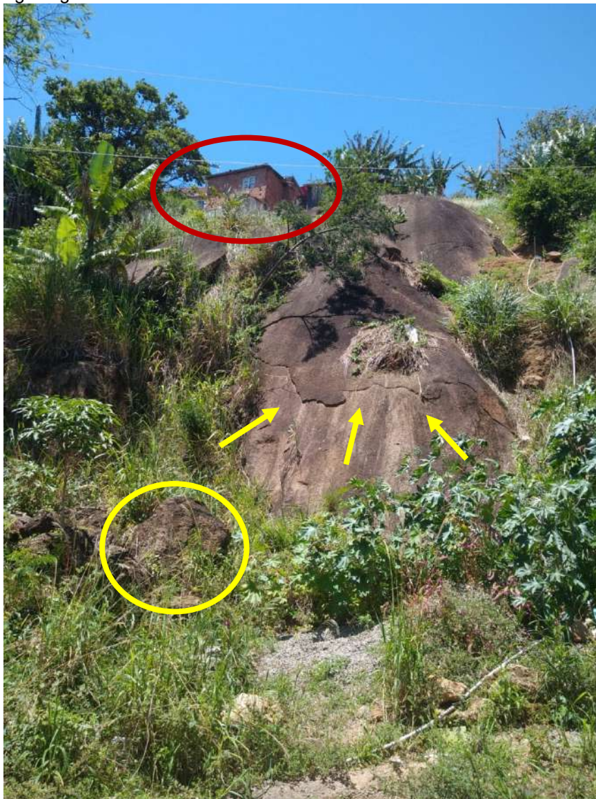
Figura 16 - Afloramento rochoso com fraturamentos aparentes. Maciço de Jaburuna, Vila Velha – ES. Coordenadas UTM – Datum Sirgas 2000 – 363911,188E; 7751593,695N. Nota-se a incidência de família de fraturamentos e lascas de esfoliação (setas amarelas) e movimentação de blocos rochosos (círculo amarelo), caracterizando indícios de geodinâmica no local. No topo, observa-se a presença de domicílios (círculo vermelho), indicando a configuração de vulnerabilidade dos habitantes inseridos nesse contexto geológico.
