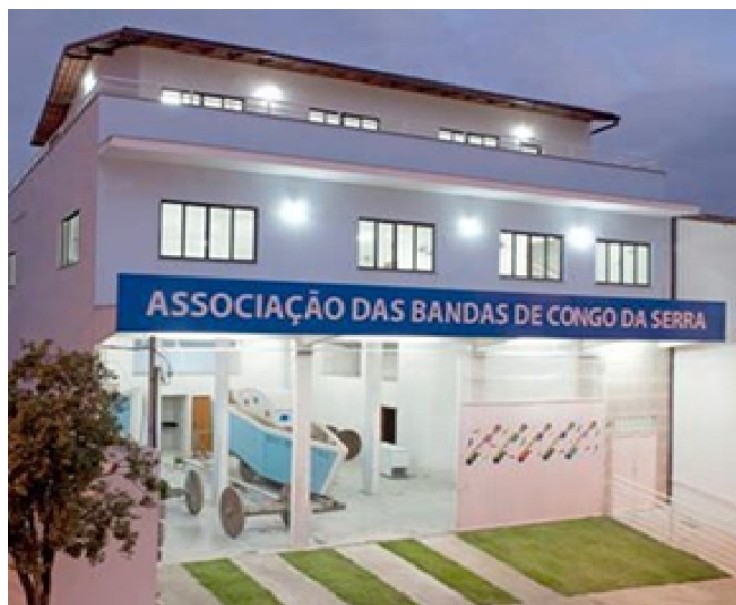
Imagem 06. Fachada da ABC-Serra.
