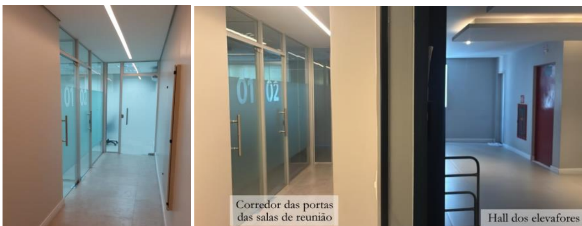
Figura 22 - Corredor das portas de vidro das salas de reunião
