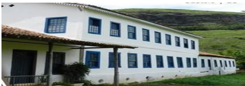
Figura 7: Foto do casarão da fazenda do Centro restaurada pelo Instituto Frei Manoel Simón.
