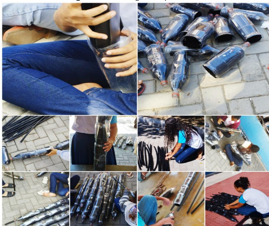
Figura 23 - Montagem do painel solar
