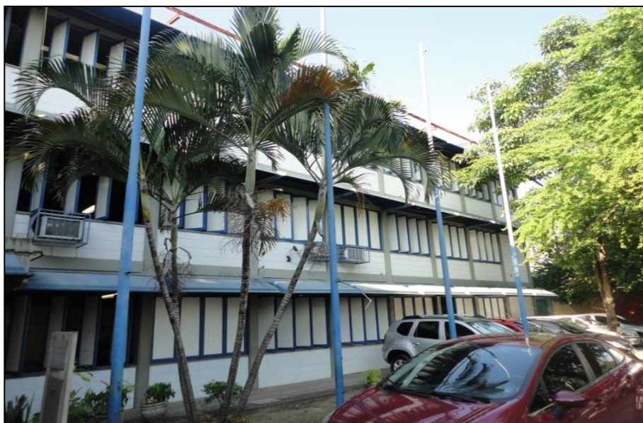
Fotografia 1- Visão da parte frontal da escola.
