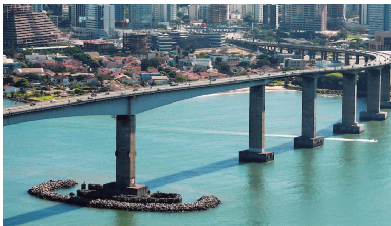
Figura 24: Imagem da Terceira Ponte (sentido Vila Velha/Vitória)
