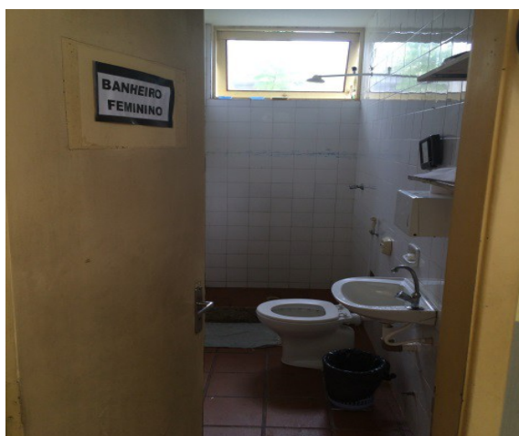
Fotografia 07- Banheiro área de serviço
