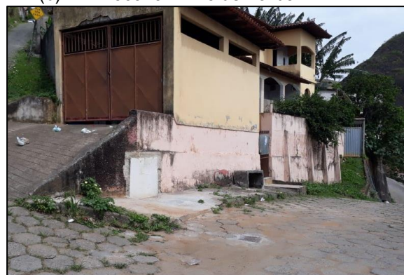
(b) EAT Joana D'Arc demolida.
