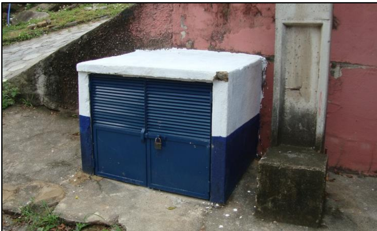
FIGURA 16 – ESTRUTURA CIVIL DA EAT JOANA D'ARC
